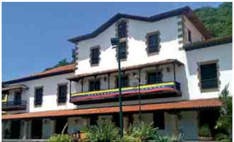
Edificio que ocuparon las dependencias de la Compañía Guipuzcoana de Caracas en La Guaira.
